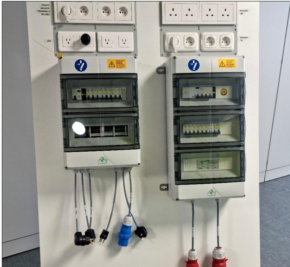
Stromversorgungseinheiten, länderspezifische Netzstecker und Steckdosen
